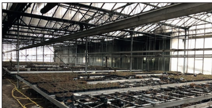
Foto 3: Danno totale a seguito di un incendio
