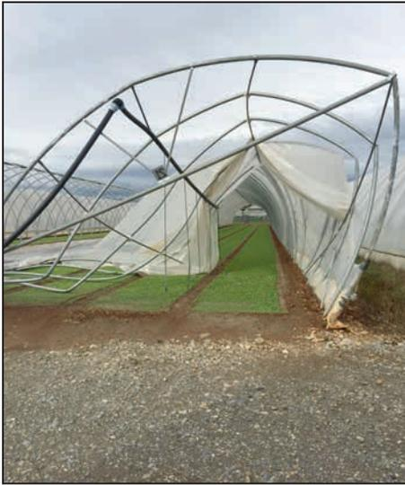
Foto 1: Tunnel singolo con tirante solo in testata; un tirante in ogni arco avrebbe ridotto gli effetti del vento sulla struttura.
