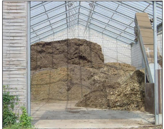
Foto 2: Magazzino per lo stoccaggio del cippato sotto vetro
